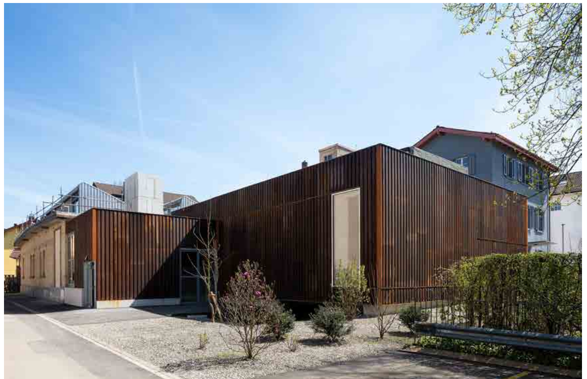
Neue Stücke in der Museumssammlung sind die Re-Use-Elemente der Fassade des Anbaus – von einem abgerissenen Schulhaus im Winterthurer Norden.
